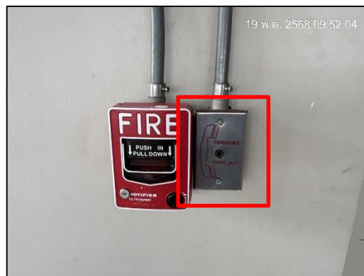
ภาพที่ 40 เครื่องแจ้งเหตุโดยใช่มือดึง (Manual Station) และโทรศัพท์แจ้งเหตุฉุกเฉินเพลิงไหม้ (Telephone Jack)
