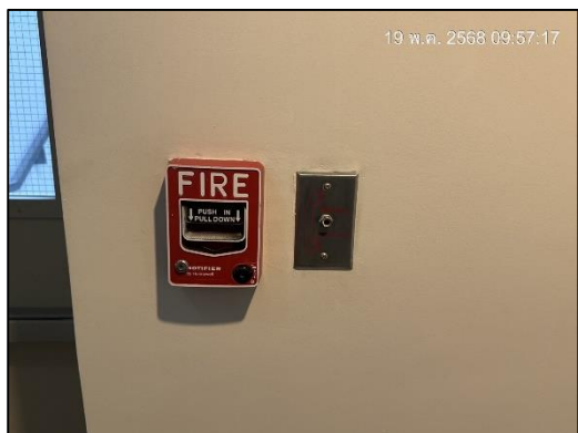
ภาพที่ 40 เครื่องแจ้งเหตุโดยใช่มือดึง (Manual Station) และโทรศัพท์แจ้งเหตุฉุกเฉินเพลิงไหม้ (Telephone Jack)
